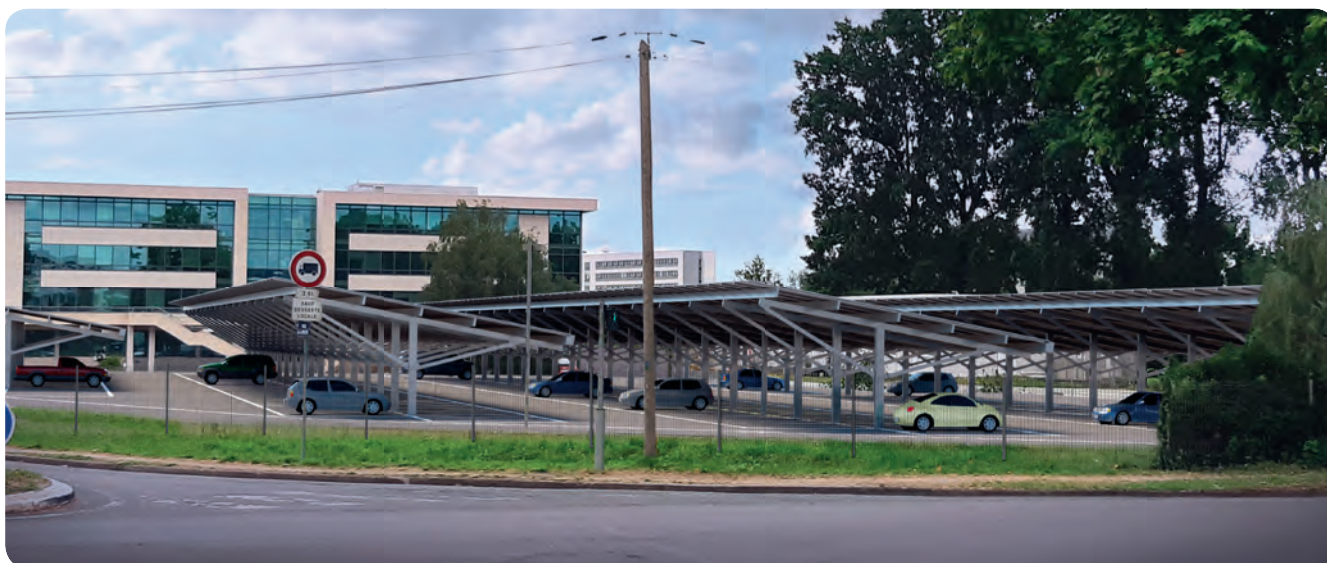
Ombrières photovoltaïques sur le parking d'un immeuble d'exploitation du Campus niortais
